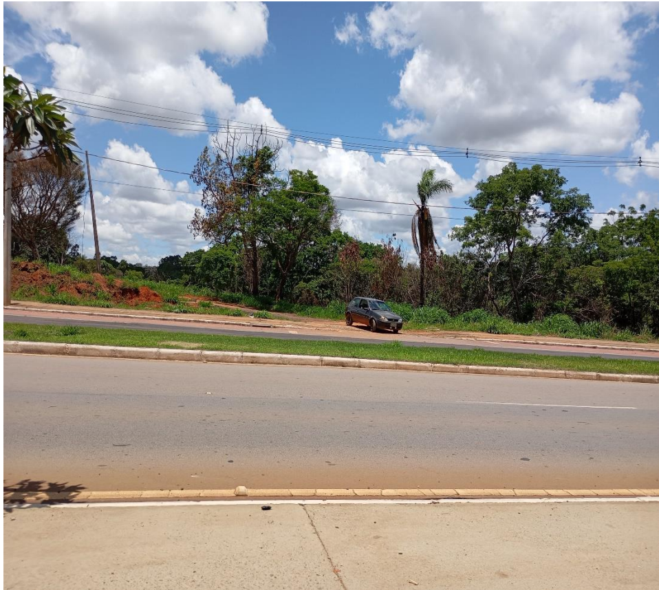
Figura 11 - Vista Estrada Vicinal
